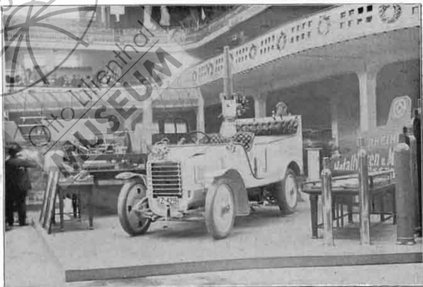
Von der J1a: Halbgepanzertes 60 PS Automobil zur Ballonverfolgung, erbaut von der Rheinischen Metallwarenfabrik, Gesamtgewicht inkl. Munition und 5 Mann Bedienung 3200 kg. Grösste Schussweite bei 43 Grad Erhöhung 7800 m. Die Munition besteht aus 100 Schrapnell- oder Granatpatronen.
