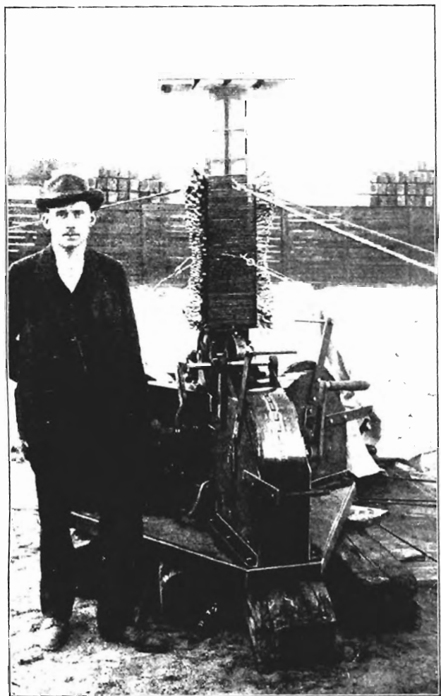
Fontanamastträger beim Aufrichten.
