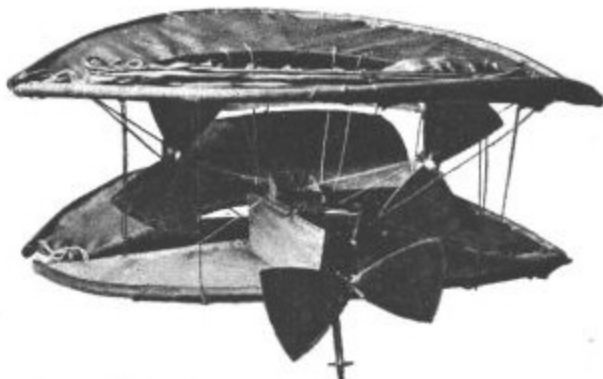
Der englische Zweidecker M. V. Der Fallschirm, der nur beim Abwärtssturz benutzt wird, geschlossen.
