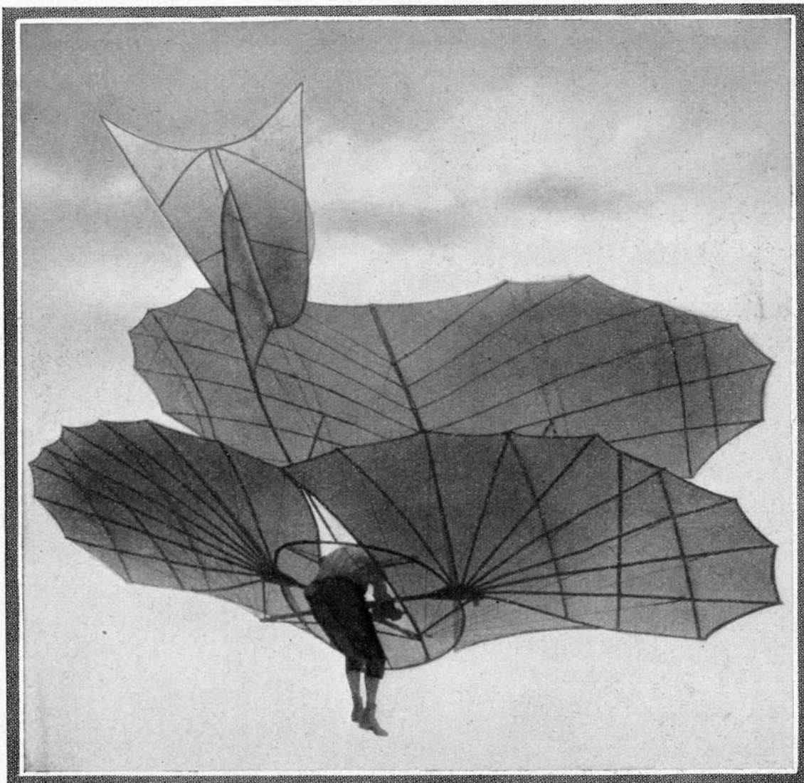
Eine historische Aufnahme aus dem Jahre 1895: Otto Lilienthal, der deutsche Bahnbrecher der Fliegerei, beim Gleitflug in einem seiner primitiven Doppeldecker. Der Apparat war aus Weidenruten mit Stoffbespannung konstruiert; er hatte 5½ m Spannweite und eine Tragfläche von 18 qm. Schließlich legte Lilienthal Strecken von über 300 m zurück. Am 9. August 1896 stürzte Otto Lilienthal bei einem Flugversuch in den Rhinower Bergen tödlich ab.
